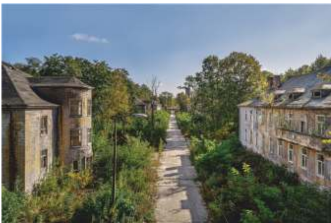
Der jetzige Zustand.
