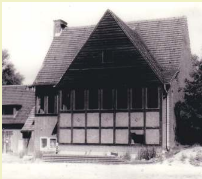
Zustand vor dem Umbau
