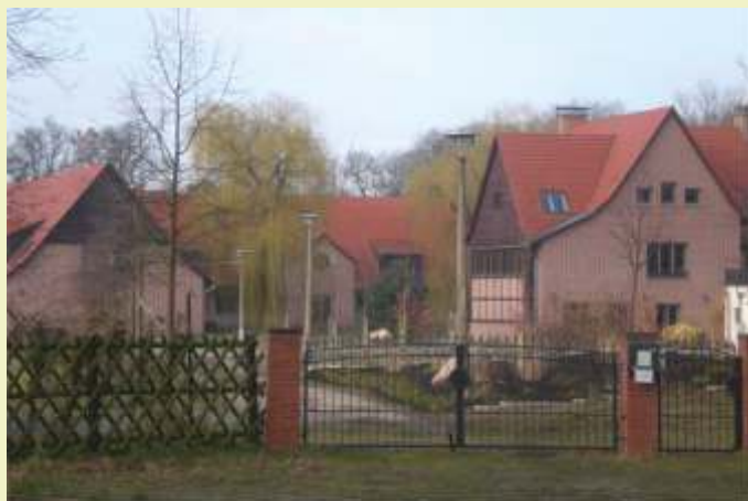
Nach dem aktuellen Umbau
