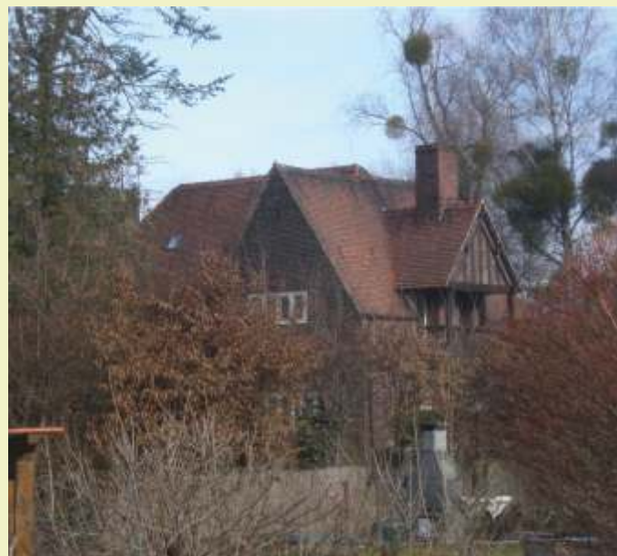
Das Verwalterhaus am Fahrländer Damm
