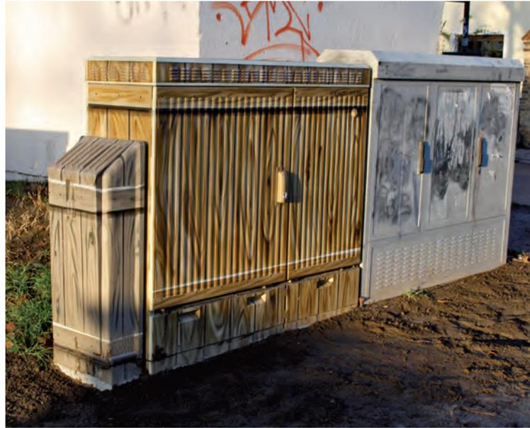
30 solcher „Kabelverzweiger“ in Fahrland mussten ausgetauscht werden, um die höhere Verbindungsqualität im digitalen Netz zu erreichen.
