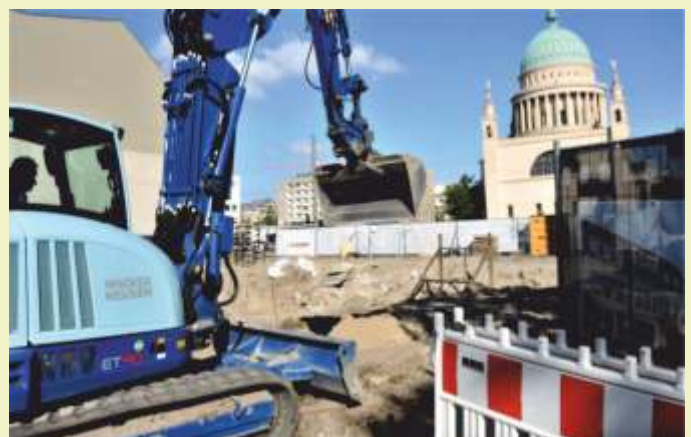
...der Synagogenbau in Potsdam beginnt.
