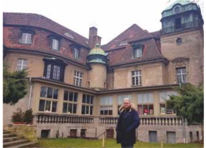
Christian Schulze präsentiert die gesamte Erneuerung der Fenster entsprechend des Denkmalschutzes
