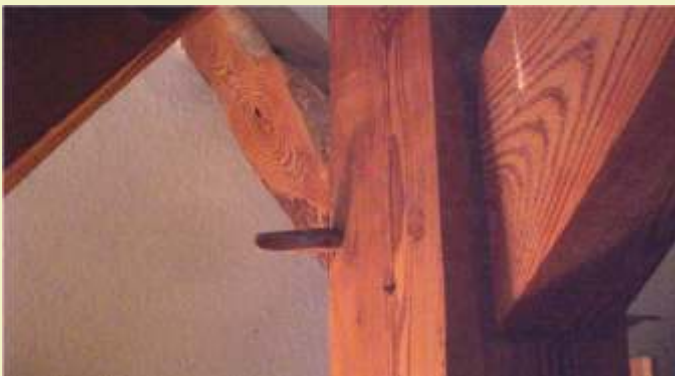
Die eisennagellose Verbindung des Gebälks mit Holzstiften
