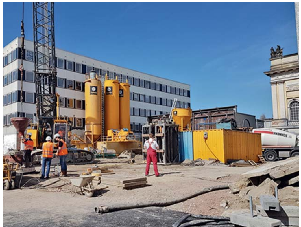
Die Bauarbeiten für das Fundament des neuen Garnisonkirchturms kommen voran
